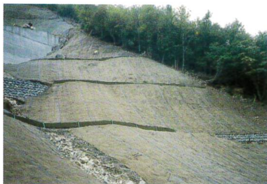
袖部に施工された緑化柵と緑化マットの施工状況
