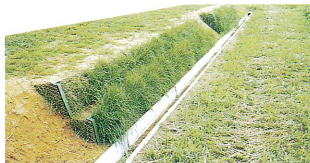
施工後2ヶ月の状況
