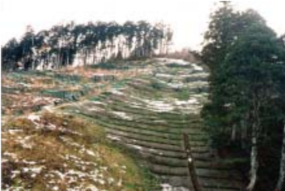
施工後約2ヶ月(11月)
