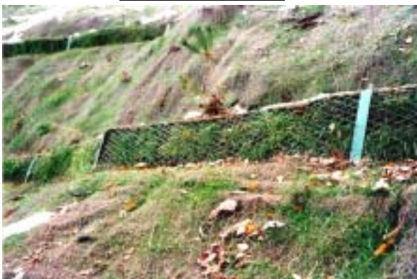
緑化柵の緑化状況
