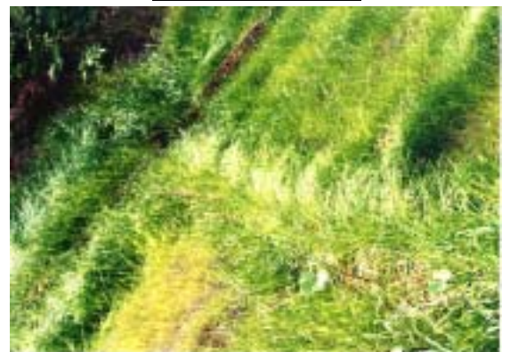
緑化柵の緑化状況
